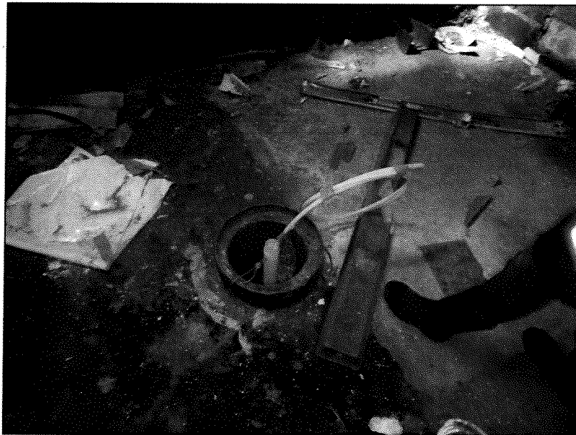
Ancien forage industriel
