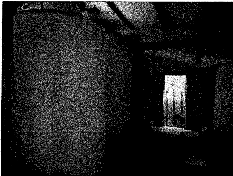
Station de traitement des effluents
